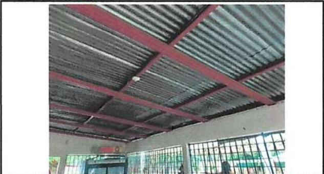
Foto 2: Desmontaje, pintura y montaje de estructura metálica de techo. ✓
